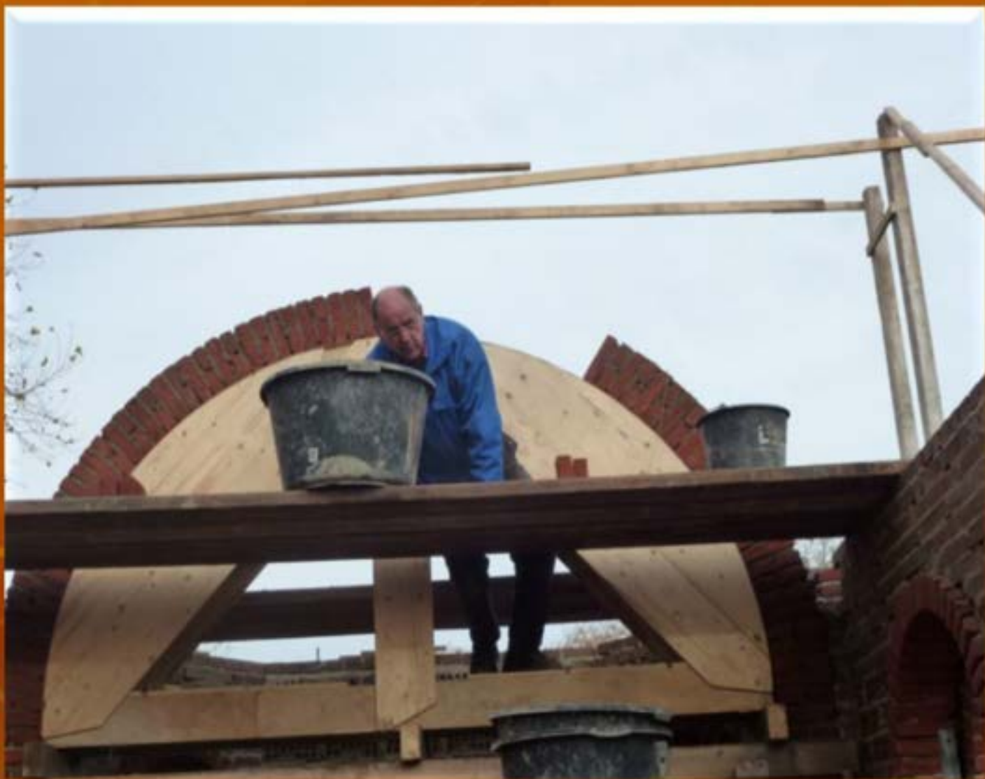
Dré Janssen legt laatste hand aan rollaag
